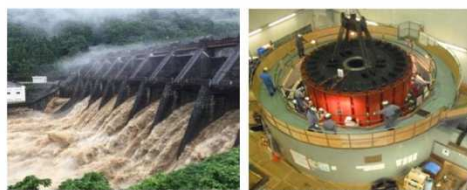
災害発生を防ぐ適切な放流対応 水車発電機のオーバーホール 保有する知見・技術力を横展開し、貢献
