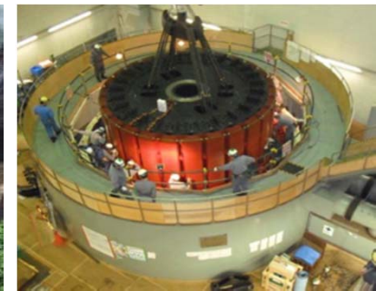
水車発電機のオーバーホール
