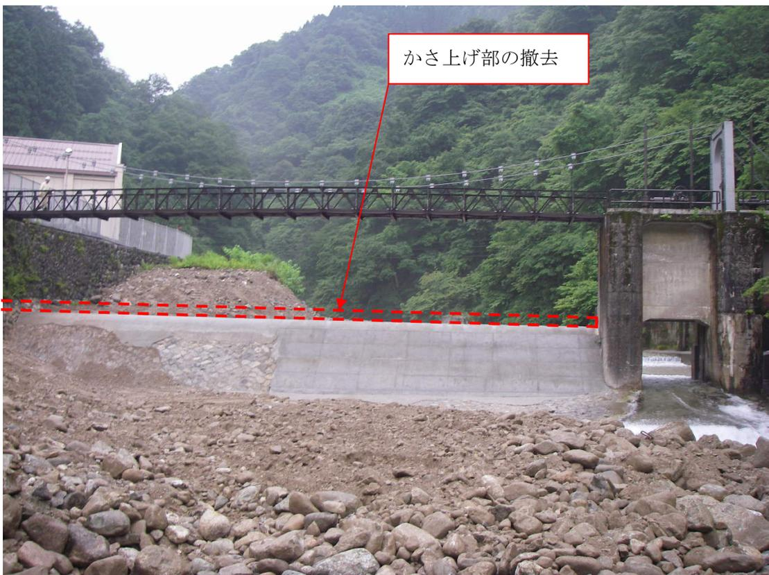
※かさ上げ部の撤去に合わせて、取水ダム下流面の石張り部分を補修
