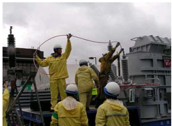
移動変電所・・・運転中の変電設備と同等の変圧器、開閉器、電力用ケーブル、配電箱などをコンパクトにまとめて移動可能としたもの。運転中の変電設備を点検・修理するときや故障したときに代替として使用される。
