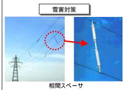
送電線の間隔を確保し,着雪や強風による電線どうしの接触を防止します。
