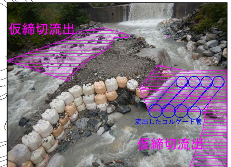
写真-2 仮締切流出後 (下流より上流を撮影)
