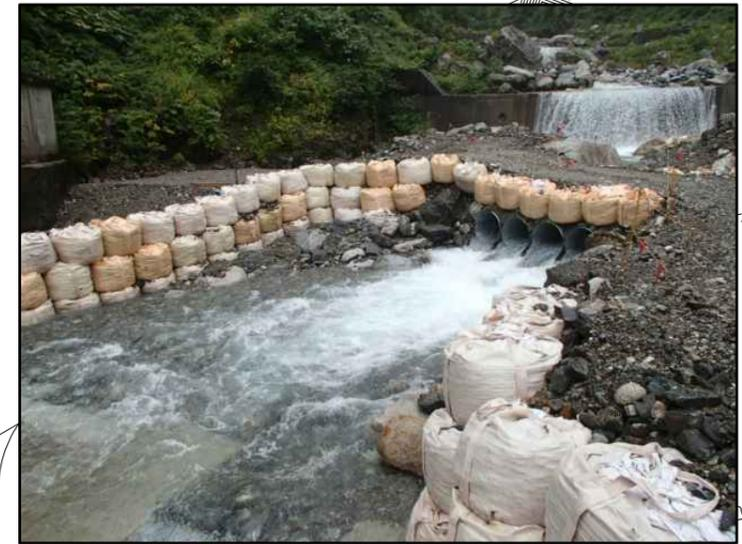
写真-1 仮締切設置状況 (下流より上流を撮影)
