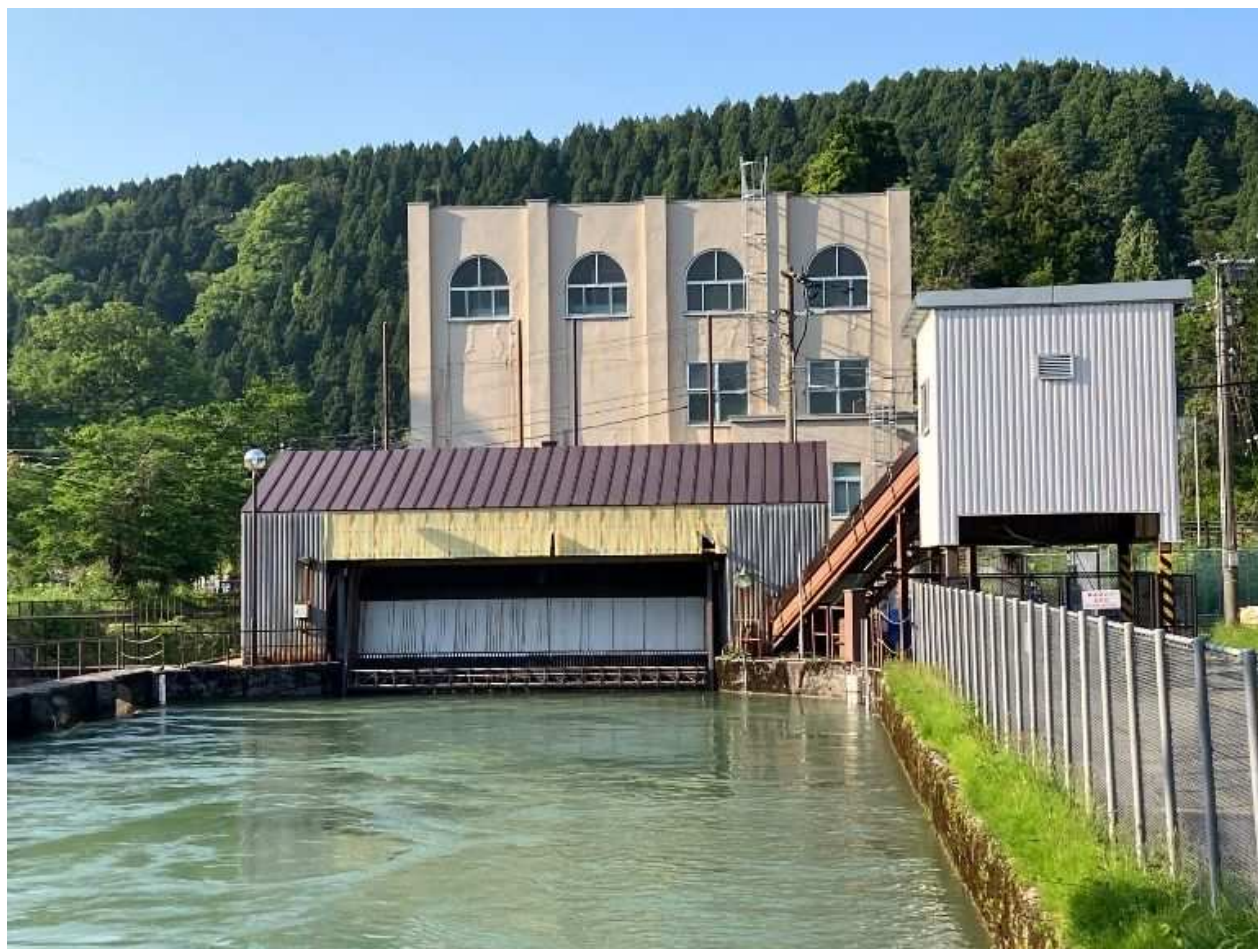
白山発電所 全景
