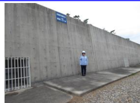
防潮堤の設置
