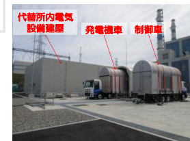
常設代替交流電源設備の設置
