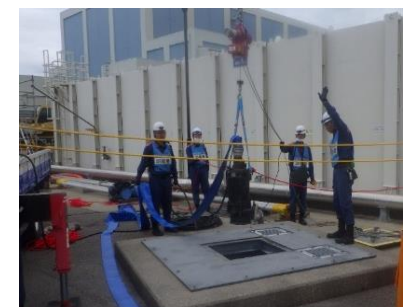
② 水中ポンプの吊上
