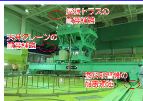
耐震安全性向上工事
