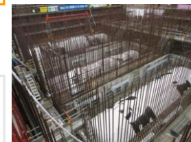
地下式軽油タンクの設置 (2017年1月)
