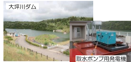
取水ポンプ用発電機
