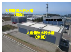
大容量淡水貯水槽の設置
